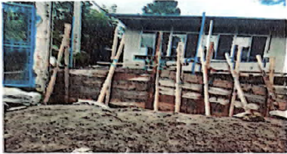
Foto 1: Proceso de construcción del muro perimetral de block con tubo HG y malla galvanizada, soleras.
