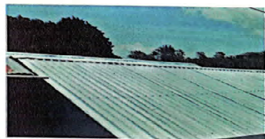
Foto 6: Trabajo de sustitución de capote
