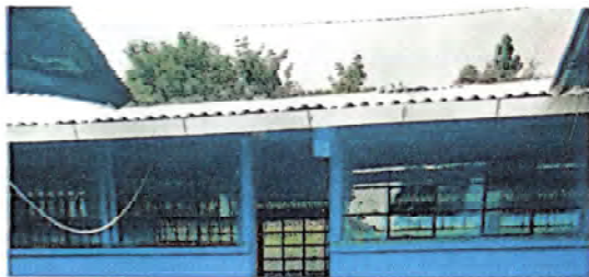
Foto 3: Proceso sustitución de canales de PVC alto caudal con pescantes de 1 x 3/16@ 1.00m
