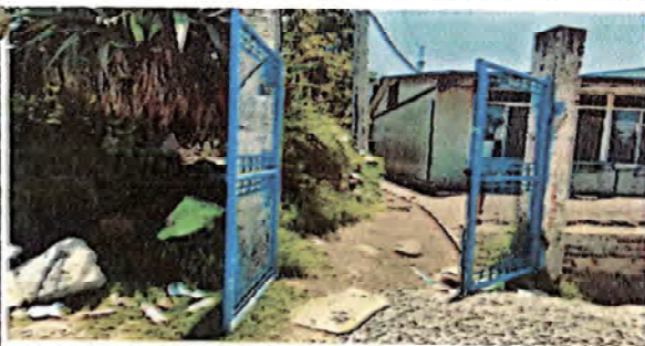
Foto 5: Proceso de mantenimiento del portón
