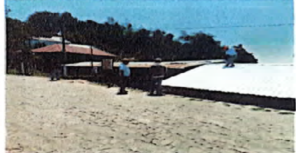
Foto 2: Trabajando la sustitución de lámina por lamina troquelada aluzinc calibre 26.
